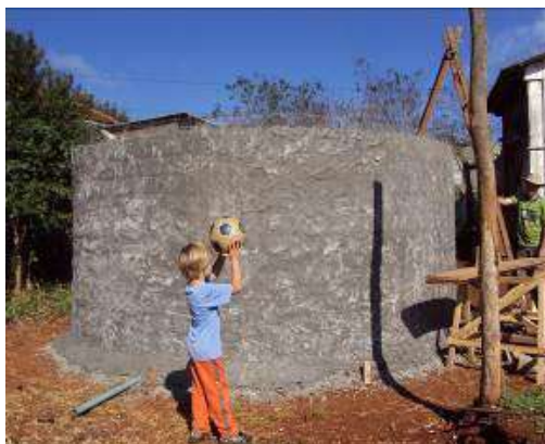
Figura 4: Parede com massa
