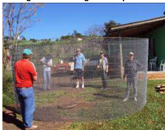
Figura 2: Montagem das paredes
