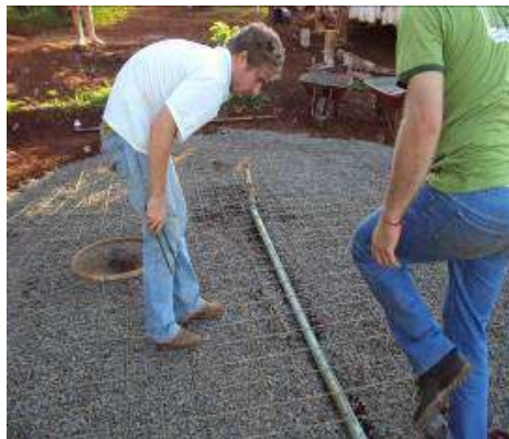
Figura 3: Montagem da malha e do cano para limpeza
