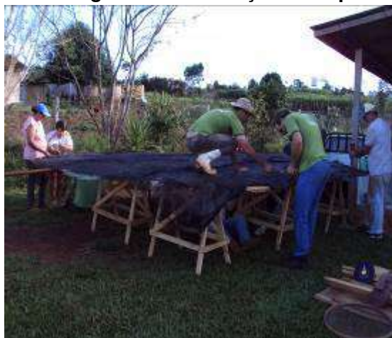
Figura 6: Construção do topo
