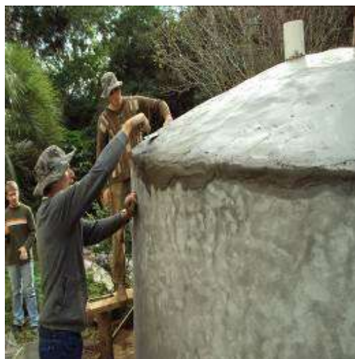
Figura 11: Fixação da massa
