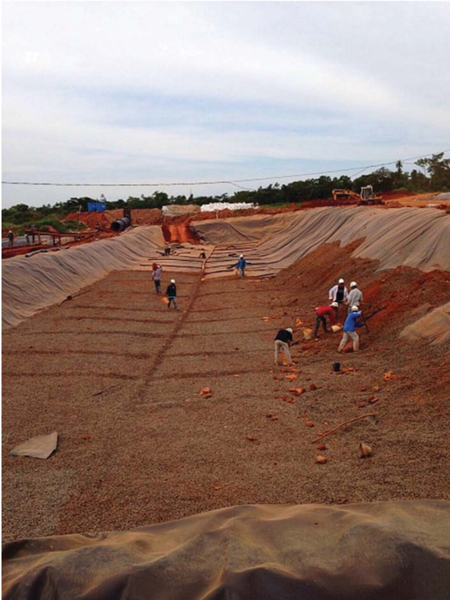
Figura 1: Construcción de estanque de lixiviación
