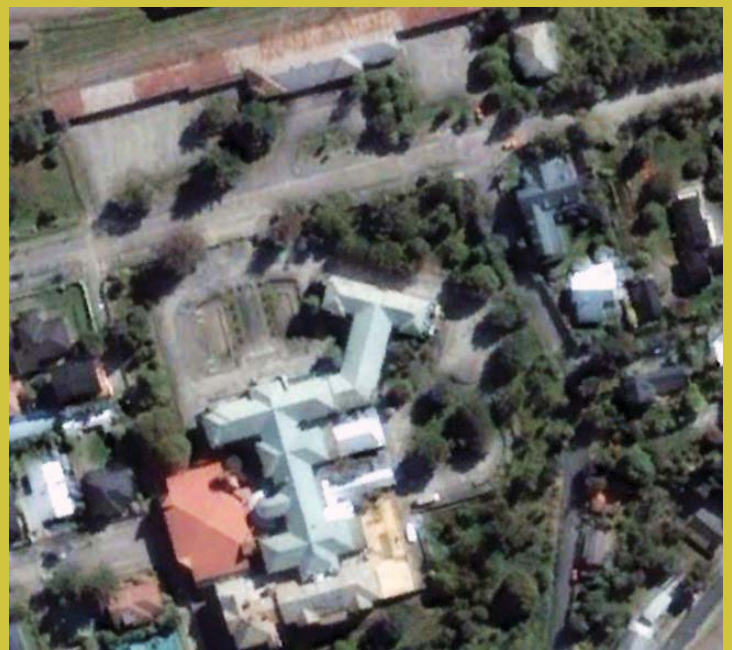
Imagen satelital que muestra, en la parte superior, la estructura longilínea de la estación ferroviaria, el trazado lineal de la calle Klenner y la planta y techumbre quebradas del hotel.
