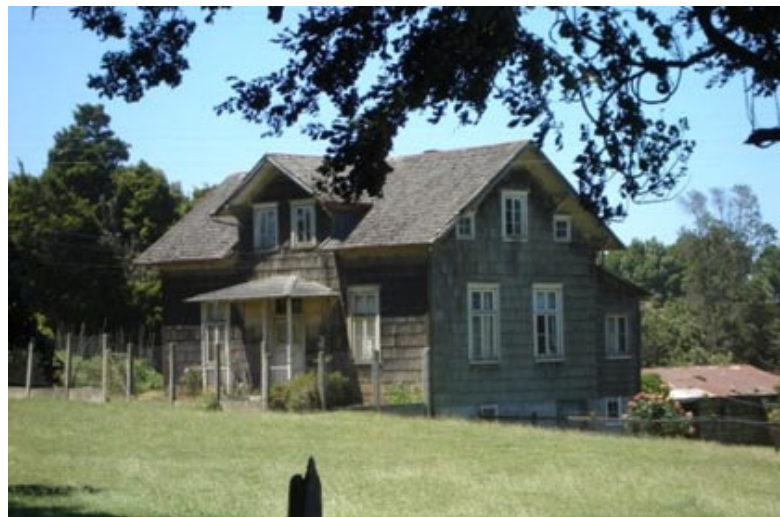
Vivienda en el camino entre Puerto Varas y Frutillar
