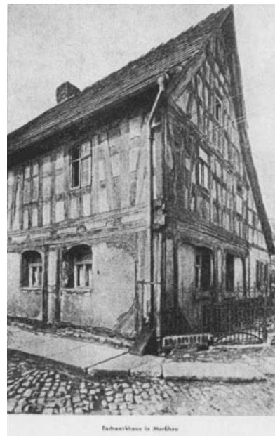
Adaptación del sistema constructivo. Fachwerkhaus in mutschau.
