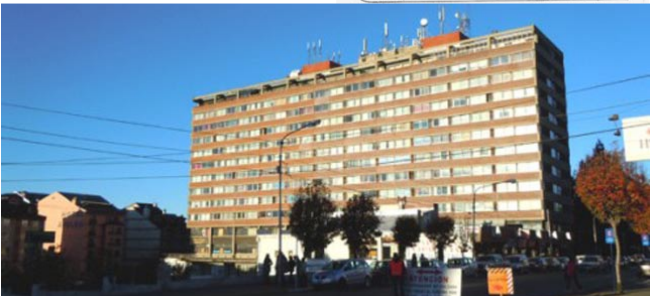
Perspectiva de proyecto. La obra en la actualidad (Fte: diario Río Negro; jul. 1972. Foto Lolich, 2011)
