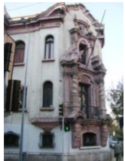
Figura 6 - Casa Ariztía. Chile
